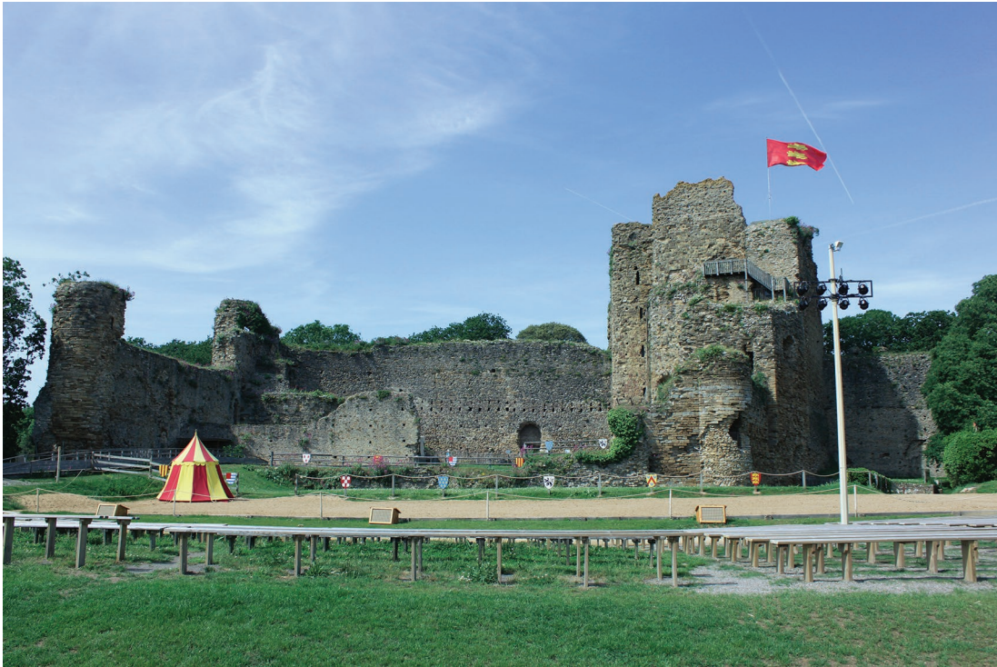
Fig. 2. — Courtine nord et tour maîtresse du château de Talmont (crédits photo C. Viaut).
