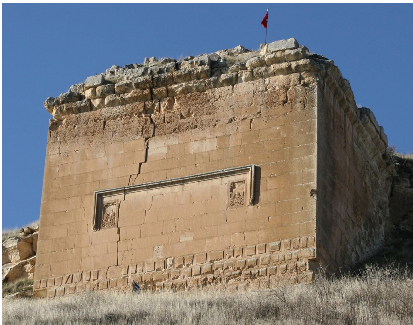
Fig. 17.13. Cilicie. Hromklay. Façade est du soubassement d'une église (cathédrale catholicossale ?). Photo Maxime Goepp
