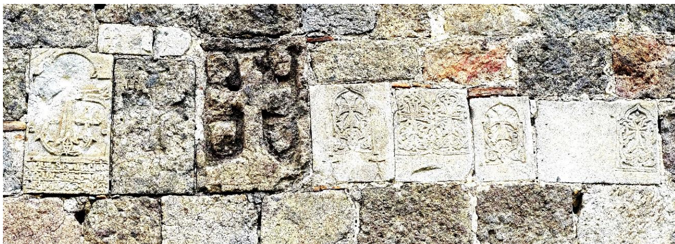
Fig. 17.62. Trébizonde (Pont). Église du monastère St-Sauveur de Tous, façade sud. Photo Hrair Hawk Khatcherian
