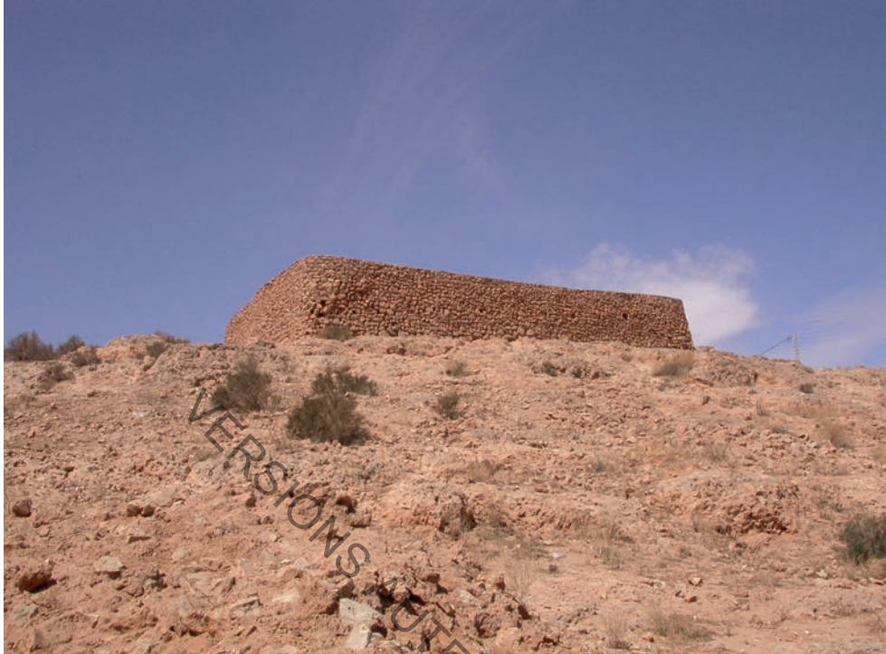
Fig. 11. Le qsar de 'Awlawāl. Extérieur de la muraille (photo Y. Montmessin, 2010).
