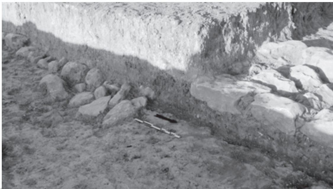
Fig. 8 : Rupture nette dans le niveau des soubassements de 179 au sud et de 104 au nord (Mission archéologique du Peramagron).
