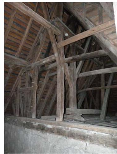
Fig. 3 : Travée de raccordement sur une sablière en réemploi © Mélinda Bizri.
