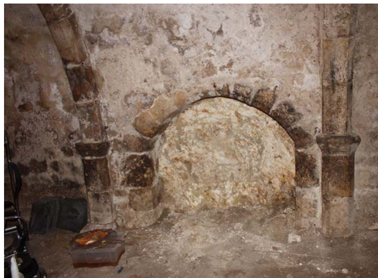
Fig. 9 : Détail des niches et arcs doubleaux de la cave © Mélinda Bizri.
