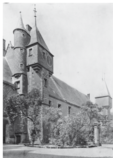
Fig. 4 et 5 : Vues des terrasses en jardin - cour nord © Médiathèque de l'architecture et du patrimoine.
