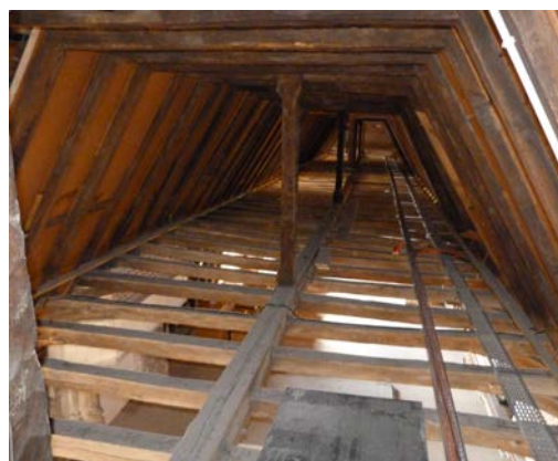
Fig. 3 : Charpente du corps de galerie (salle Desportes) © Mélinda Bizri.
