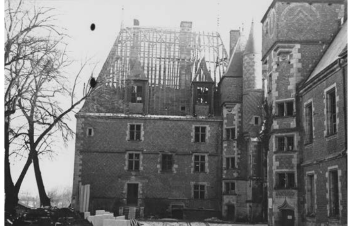
Fig. 21 : Vue de l'aile est après l'incendie de juin 1940 qui a ravagé la toiture suite au bombardement © Médiathèque de l'architecture et du patrimoine.
