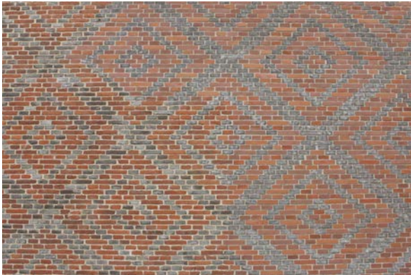
Fig. 6-7-8-9 : Jeux de décor avec briques surcuites © Mélinda Bizri.
