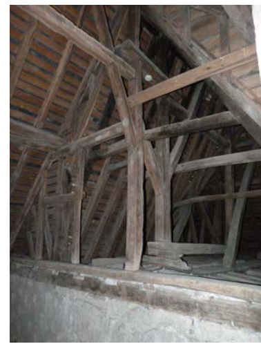
Fig. 3 : Travée de raccordement sur une sablière en réemploi © Mélinda Bizri.
