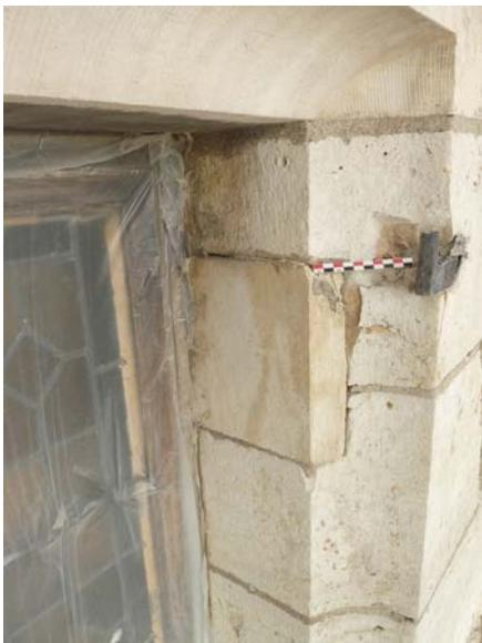
**Fig. 6** : Moulure à cavet, fenêtre à meneau, 1<sup>er</sup> étage © Département du Loiret - SAP.
