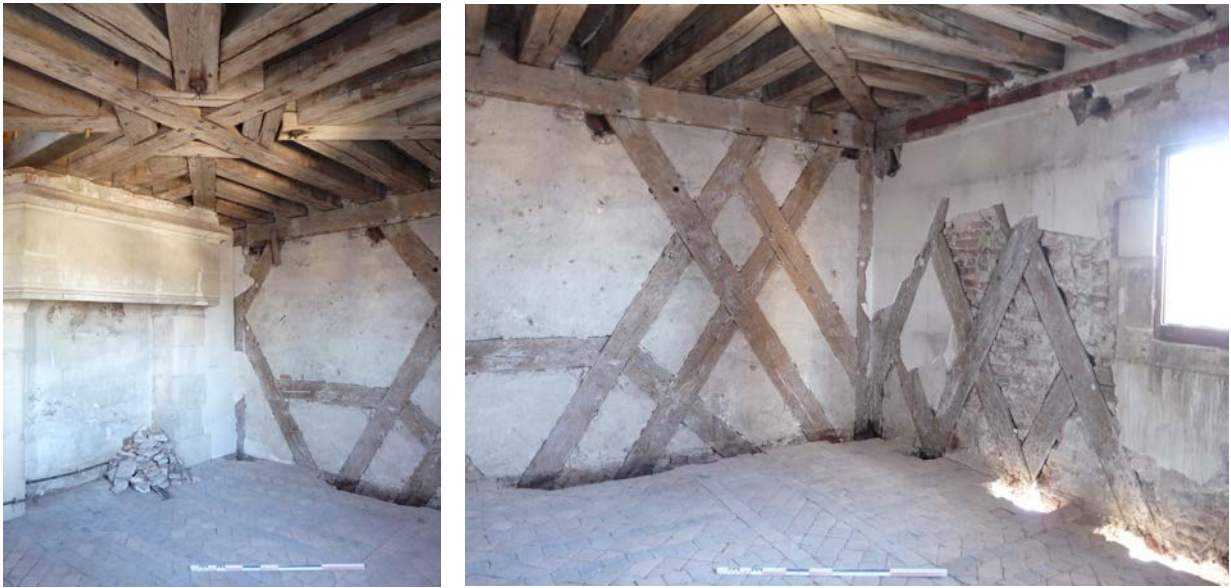
Fig. 3 : Ossature bois de la chambre haute nord © Département du Loiret - SAP.
