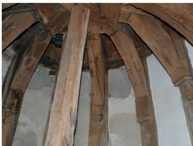
Fig. 7 : Aisseliers sculptés de la tourelle d'escalier de la tour ouest (Bizri, Marchant, Perrault 2019).
