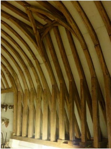
Fig. 8 : Lucarne de combles (emplacement fermé), charpente ouest © Christophe Perrault.
