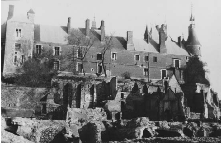
Fig. 20 : Vue des ruines des maisons accolées au coteau sud après le bombardement de 1940 : les toits du château ont subi des dommages, ils sont recouverts de cartons bitumés et de bâches © Médiathèque de l'architecture et du patrimoine.
