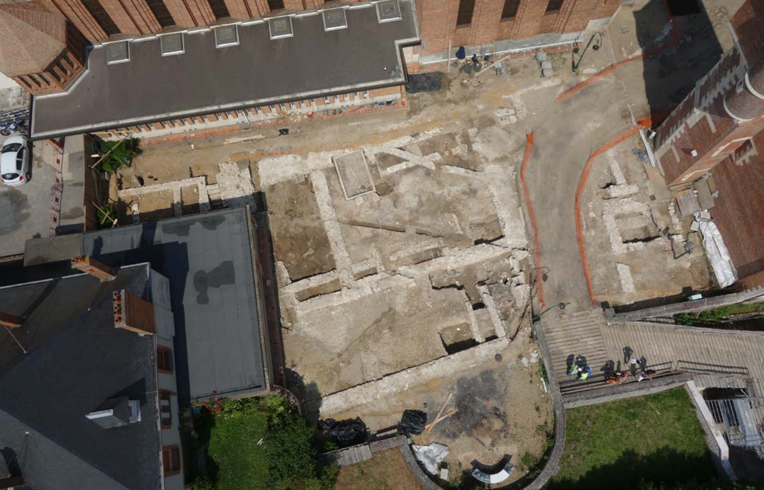
Fig. 4 : Vue zénitale de l'aile disparue, Belvédère Ouest en cours de dégagement (fouilles de 2013) © Département du Loiret - SAP.
