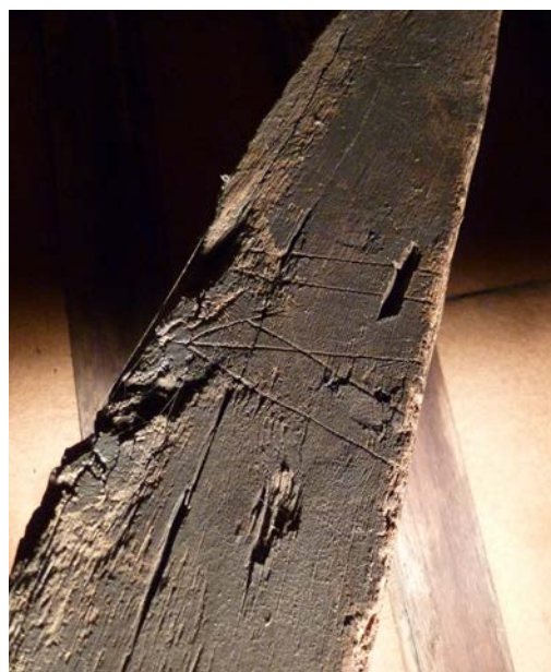
Fig. 4 : Marque d'assemblage sur la charpente de l'aile de la galerie © Christophe Perrault.
