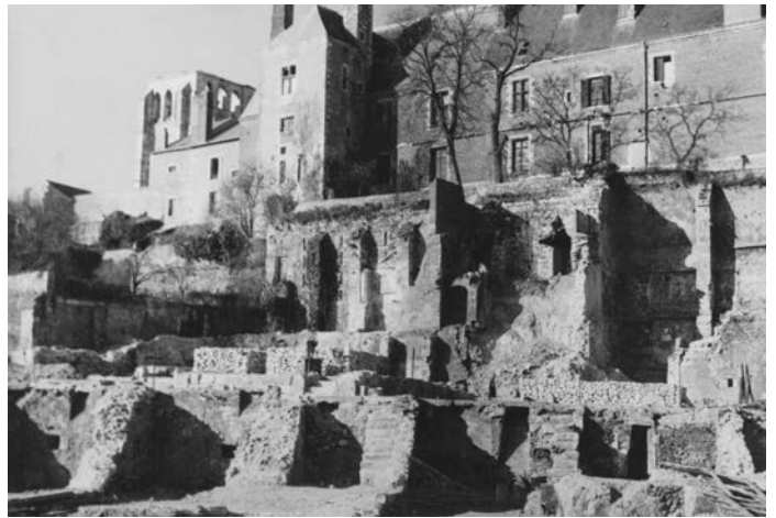
Fig. 19 : Vue des ruines des maisons accolées au coteau sud après le bombardement de juin 1940 © Médiathèque de l'architecture et du patrimoine.
