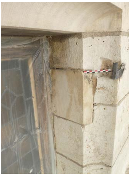
Fig. 6 : Moulure à cavet, fenêtre à meneau, 1 er étage © Département du Loiret - SAP.
