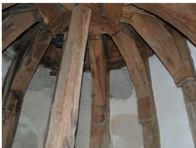
Fig. 7 : Aisseliers sculptés de la tourelle d'escalier de la tour ouest (Bizri, Marchant, Perrault 2019).
