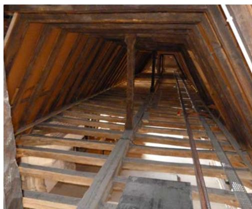
**Fig. 3** : Charpente du corps de galerie (salle Desportes)
