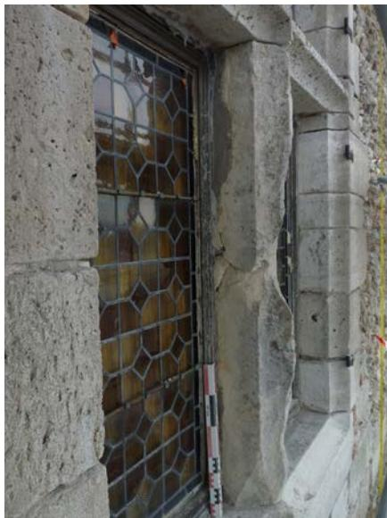
**Fig. 7** : Meneau en calcaire d'Apremont, fenêtre du 2<sup>e</sup> étage © Département du Loiret - SAP.
