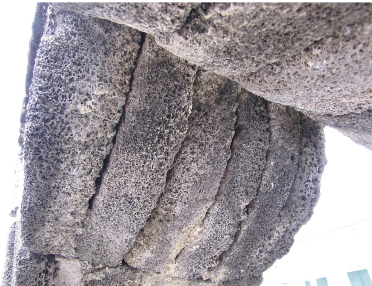
Figure 132 : Goba la Salama, détail de la voûte en berceau brisé. Kwambani, Grande Comore
