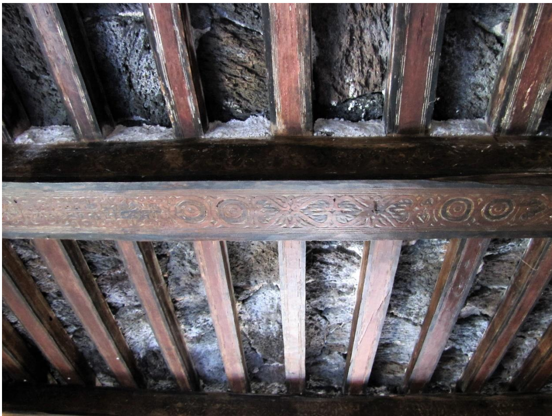
Figure 22 : Détail des poutres du palais du sultan Saïd Hussein, Fumbuni, Grande Comore
