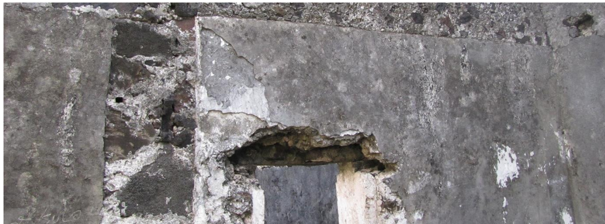
Figure 156 : Porte Ic003, détail du linteau
