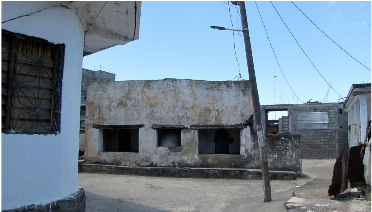
Figure 72 : Mosquée Djumbe Fumu, Ntsaweni, Grande Comore
