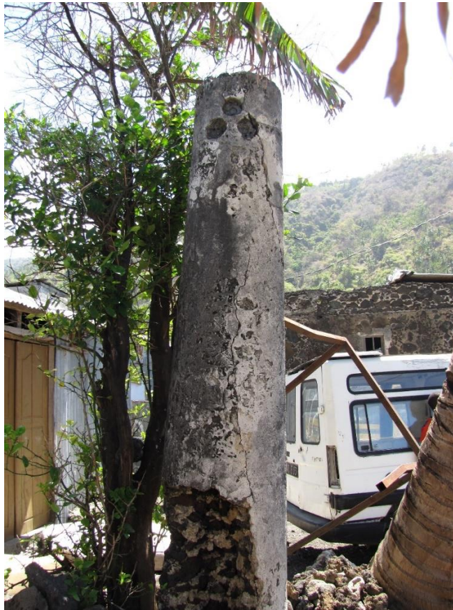
Figure 115 : Pilier isolé, Bandamadji, Grande Comore
