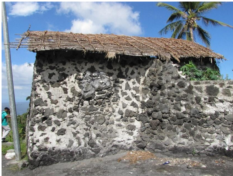
Figure 81 : Ntsudjini, bunarisi avec couvrement restitué
