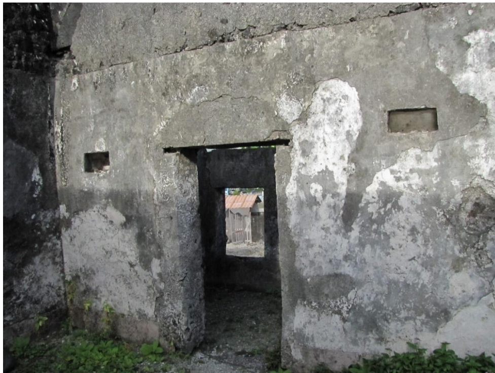
Figure 151 : Bâtiment principal, porte d'accès nord à la grande salle
