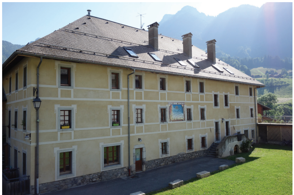
Fig. 10 - La façade sud de l'aile nord.
