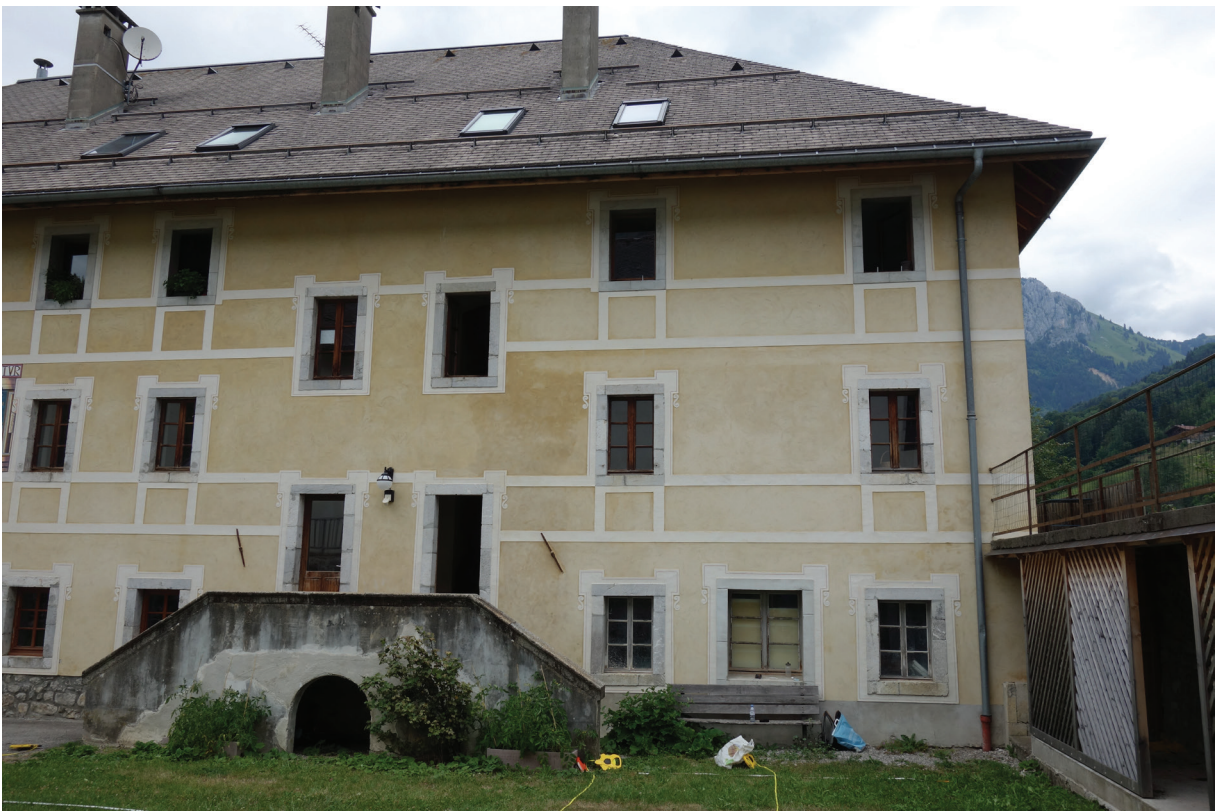
Fig. 22 - Moitié orientale de la façade sud de l'aile nord.
