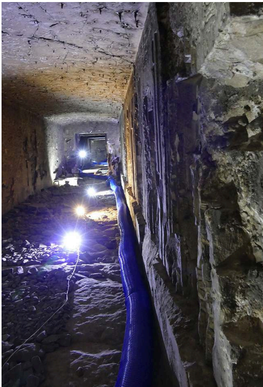
Fig. 6. Mise en place d'une gaine souple d'extraction d'air dans la tombe TT 33 à l'automne 2019 (C. Gallois).
