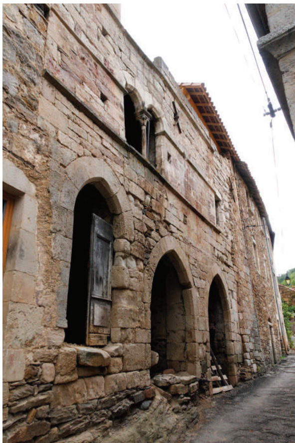
18 > Vue des maisons 3 et 4 depuis le sud (cl. L. Prysmicki).
