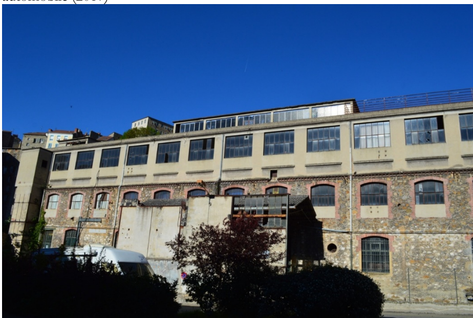
Photographie 2 : Ancien atelier des Tanneries Meyzonnier, partiellement réutilisé comme garage automobile (2017)
