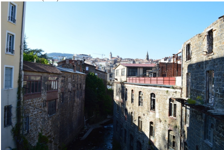
Photographie 1 : anciennes tanneries et mégisseries des rives de la Cance, en friches ou reconverties en habitations (2017)
