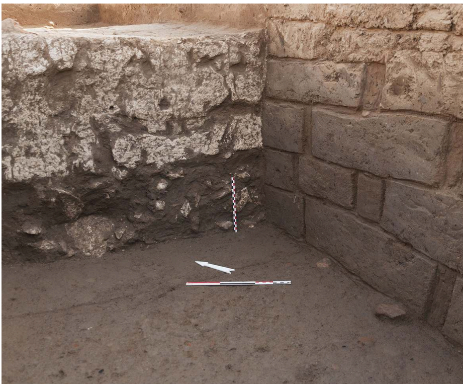
Fig. 22. Vue en coupe du mur MR 1020 et de l'enduit de chaux blanc (Y. Bourhim).
