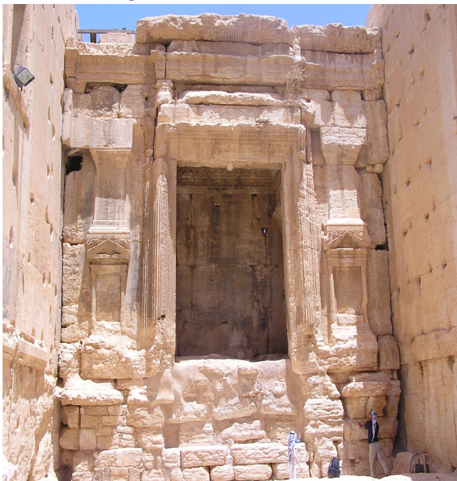
Figura 9 – Fachada interior norte
