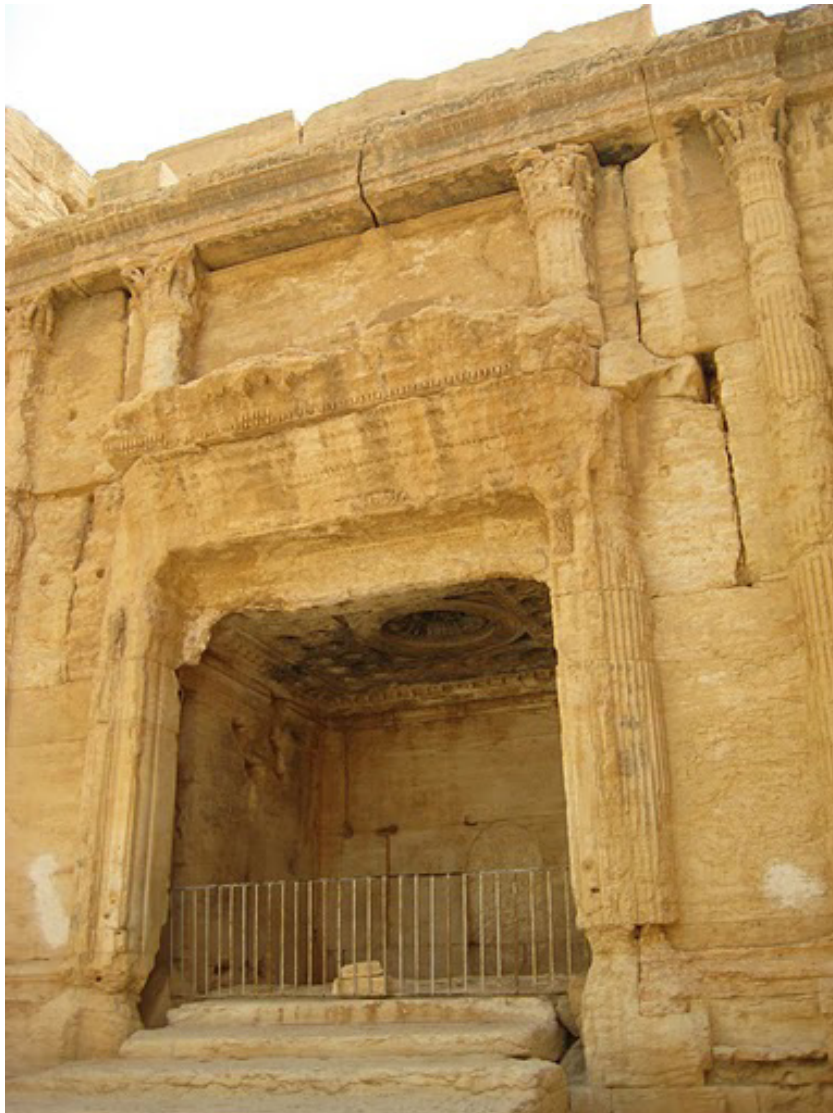
Figura 8 – Fachada interior sur
