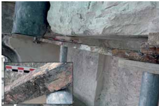
Fig. 6 – Chaînage inséré dans la corniche au sommet du mur gouttereau de la nef de la basilique de Saint-Denis avec marque de soudure relevée sur ce chaînage (Maxime L'Héritier).
