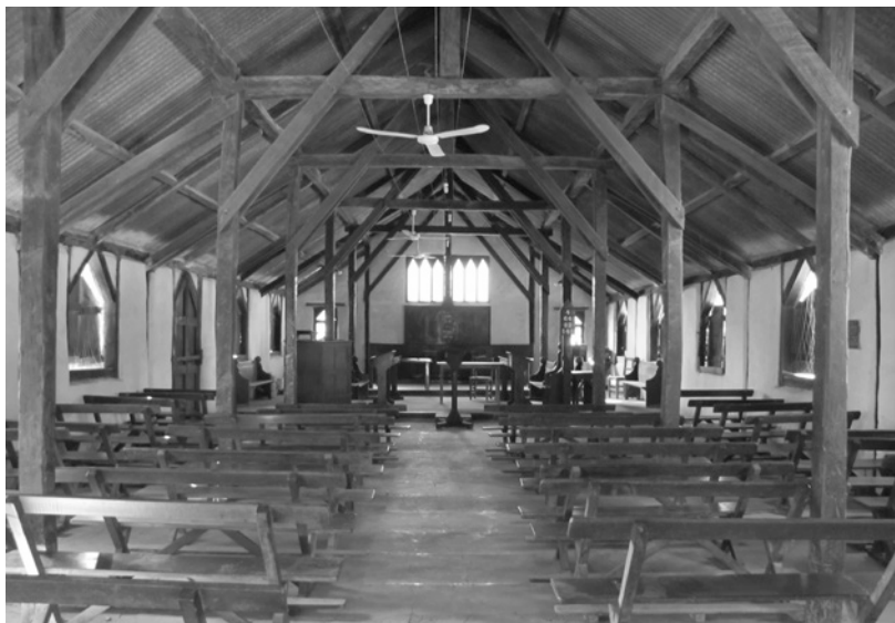
3. Interior de la iglesia de Misión Chaqueña, 2018. La iglesia se terminó de construir en 1926. Los postes y tirantes fueron labrados a mano, pero las tablas del atrio, los sillones, las puertas y las persianas se obtuvieron con una máquina muy elemental: un patín, un pozo y un serrucho manejado por dos personas. Foto del autor.
