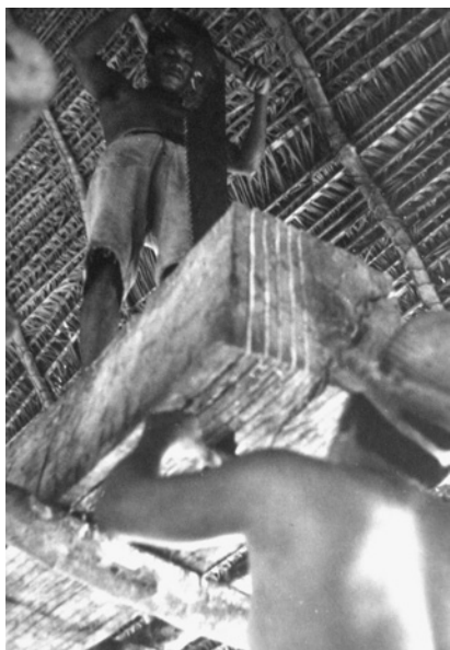
2. Aserrando las vigas de una casa en construcción en Casarabe. Fuente: ACLB, «Técnica del trabajo», sin fecha, p. 14.
