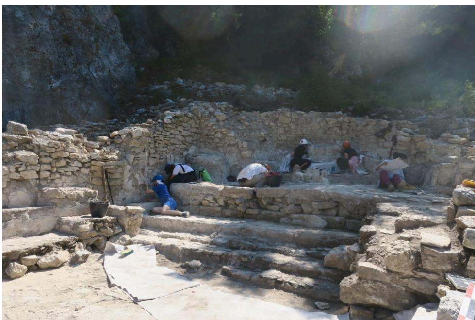
Fig. 42 – Zone 1B. Consolidation des enduits peints dans l'église.
