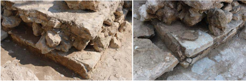
Fig. 19 – Zone 1B. Église. Podium 1989, angle nord-ouest.
