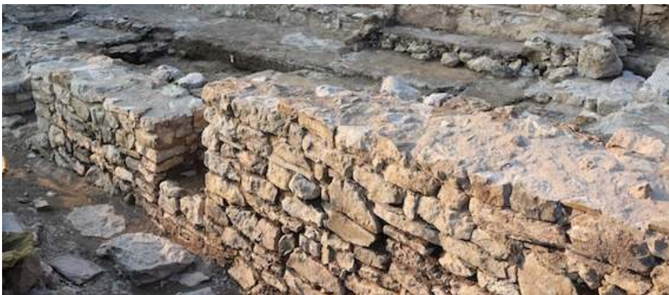
Fig. 41 – Zone 1B. Mur sud de l'église, après restauration.
