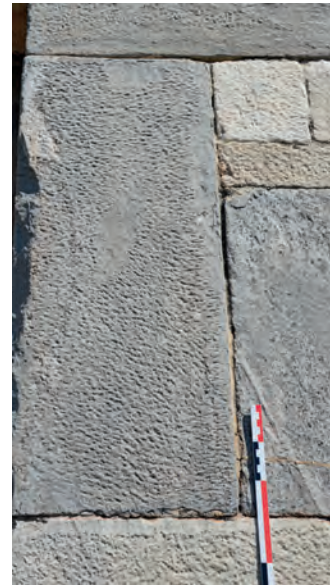
Fig. 14 – Parements grossièrement taillés à la broche du jambage de la porte sud-ouest (D. Istria/CNRS).
