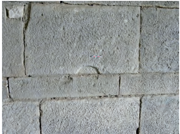
Fig. 3 – Trace semi-circulaire sur un bloc de parement intérieur du mur nord – possible emboîture (D. Istria/CNRS).
