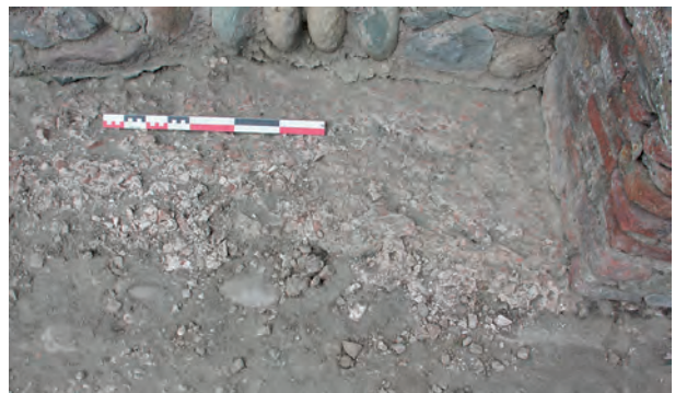
Fig. 19 – Sol en béton de chaux de la nef. On peut voir que le pilier en briques a été posé sur ce sol. Le mur en galet en haut de l'image est celui du palais épiscopal du second Moyen Âge dont la base a été restaurée après les fouilles des années 1960 (D. Istria/CNRS).
