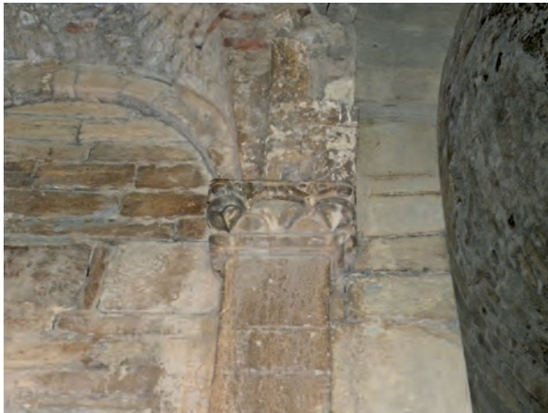
Fig. 5 – Détail du pilastre de l'espace voûté nord et de l'arc triomphal (D. Istria/CNRS).
