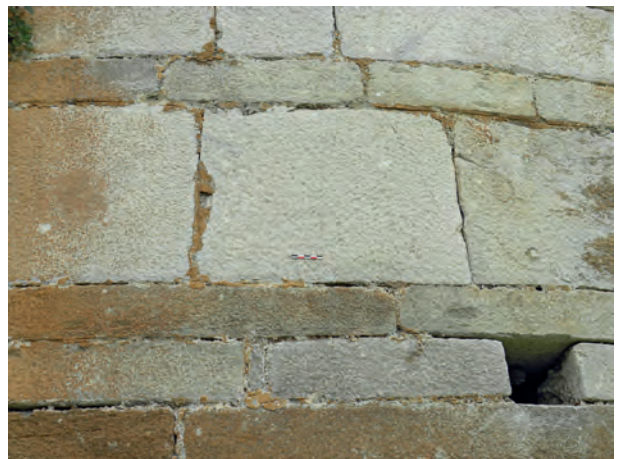
Fig. 4 – Détail du parement extérieur de l'abside. On remarque différentes techniques de taille (D. Istria/CNRS).
