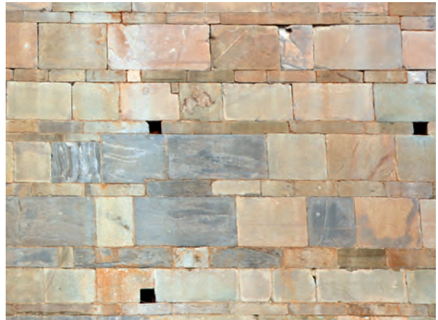
Fig. 17 – Portion du mur sud de l'édifice montrant l'alternance d'assises basses et d'assises hautes. On notera également les trous de boulins soit aménagés entre deux blocs d'une assise basse, soit façonnés dans un bloc d'une assise haute. Le rythme ABAB... est ici parfaitement respecté même si les variations de hauteur des blocs imposent quelques ajustements (D. Istria/CNRS).
