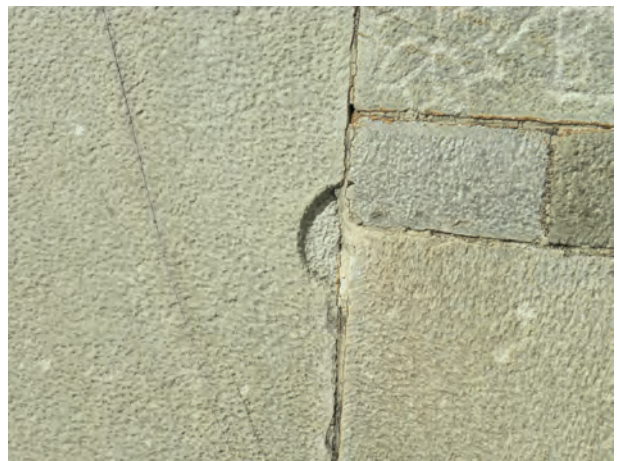
Fig. 8 – Marque semi-circulaire sur un bloc de parement – possible emboîture (D. Istria/CNRS).
