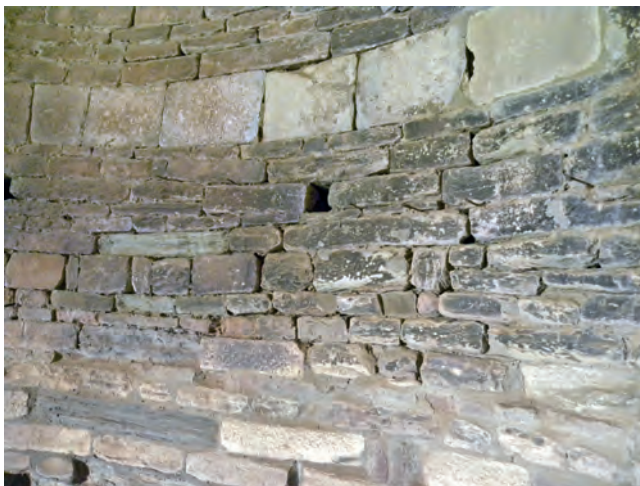
Fig. 7 – Parement intérieur du mur absidal. On note la présence d'une assise haute constituée de blocs taillés posés en délit (D. Istria/CNRS).
