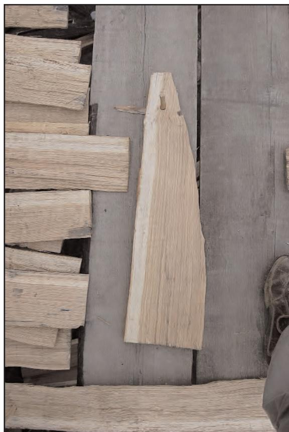
Fig. 24 : Taille biaisée des bardeaux d'arétier.
