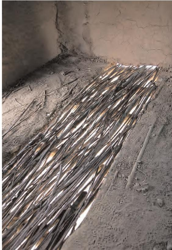
Fig. 12 : Réfection du sol avec pose de perches en châtaigniers et recouvrement en torchis.
