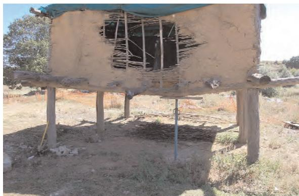
Fig. 14 : Etaient provisoire du sommier brisé en deux.
