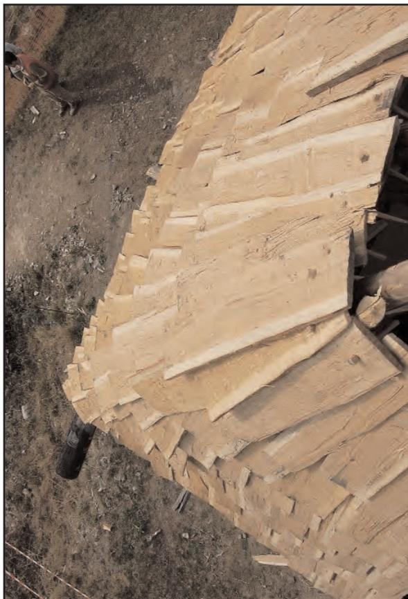
Fig. 25 : Recouvrement latéral des arêtiers.
