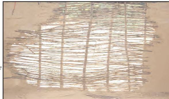
Fig. 13 : Réfection de la cloison et de son clayonnage.
