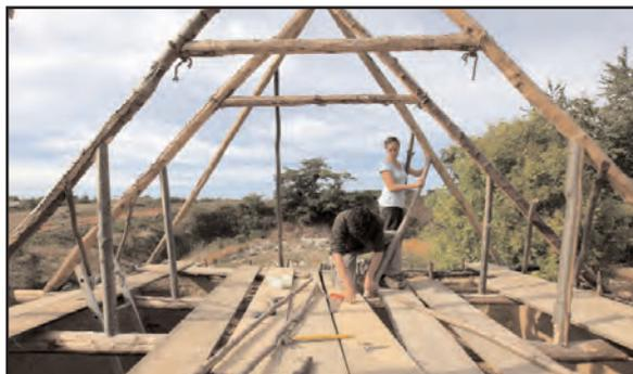
Fig. 19 : Mise en place des arêtiers et des jambes de force.
