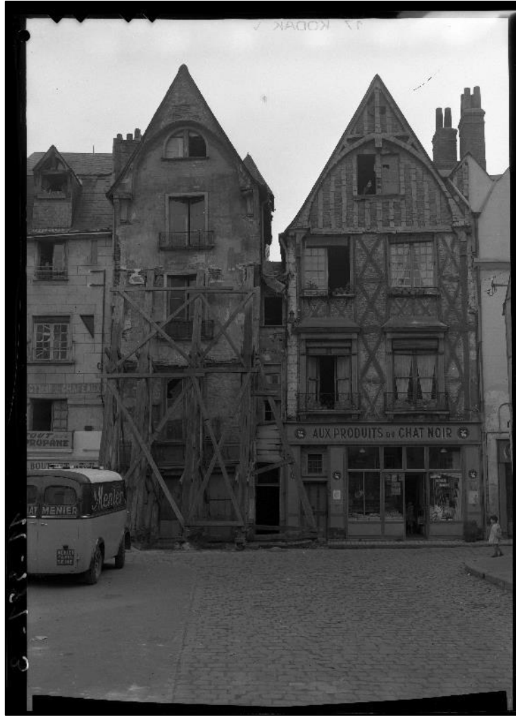
Figure 1 : Des maisons de la place Plumereau avant leur restauration.
