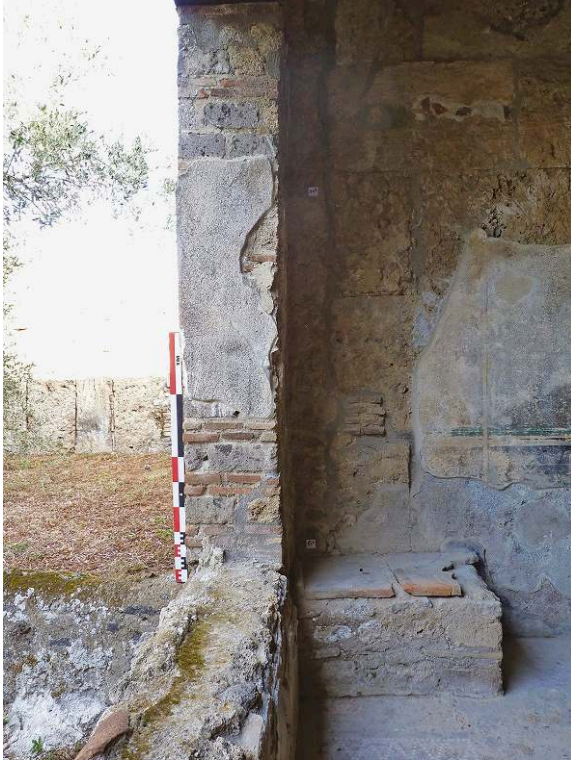
Fig. 16. Salon (15), montant nord de la fenêtre et à droite la structure 1.
