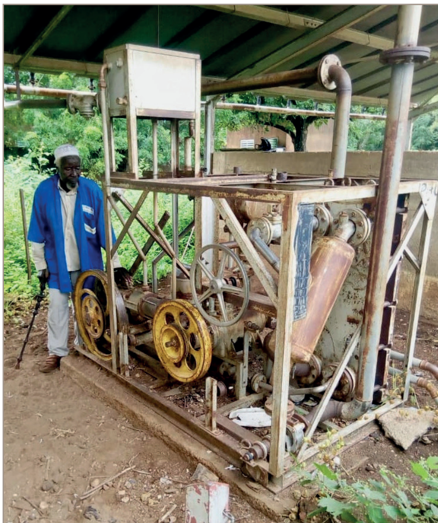
Image 5 - Souka Kagambega (décédé en octobre 2020) en novembre 2019 près d'une ancienne pompe de la Sofretes (moteur MGS 2000) partiellement conservée
