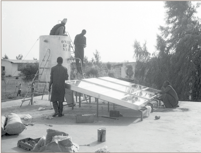
Image 4 - Techniciens de l'ONERSOL installant un chauffe-eau solaire thermique en 1972
