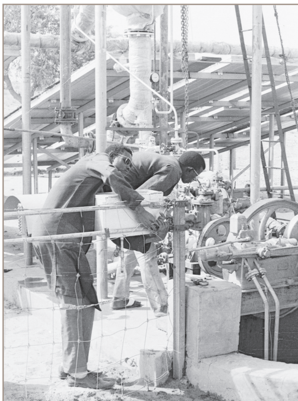
Image 3 - Techniciens de l'ONERSOL en 1972 travaillant sur la pompe solaire de Bossey Bangou
