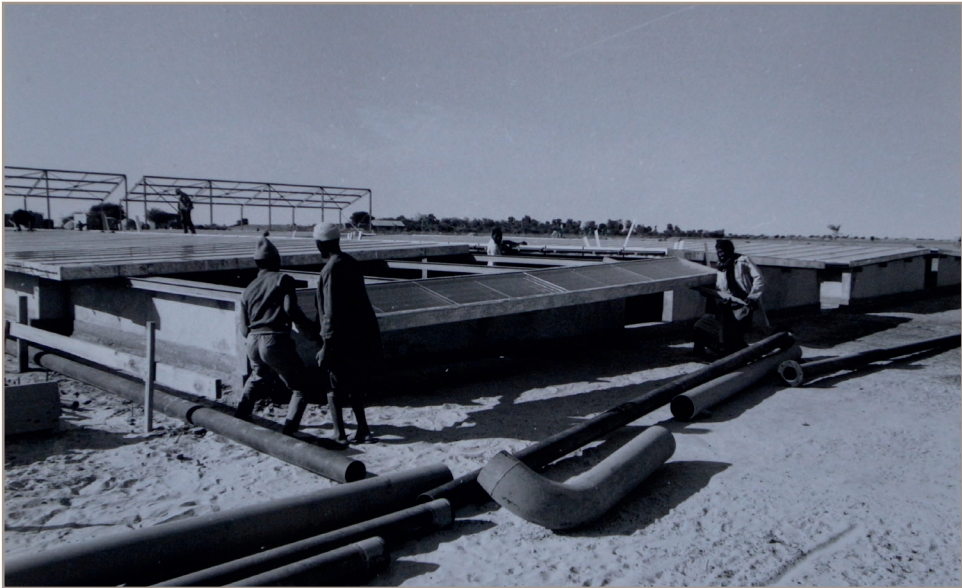
Photographie du montage des capteurs de DIRE en 1978
