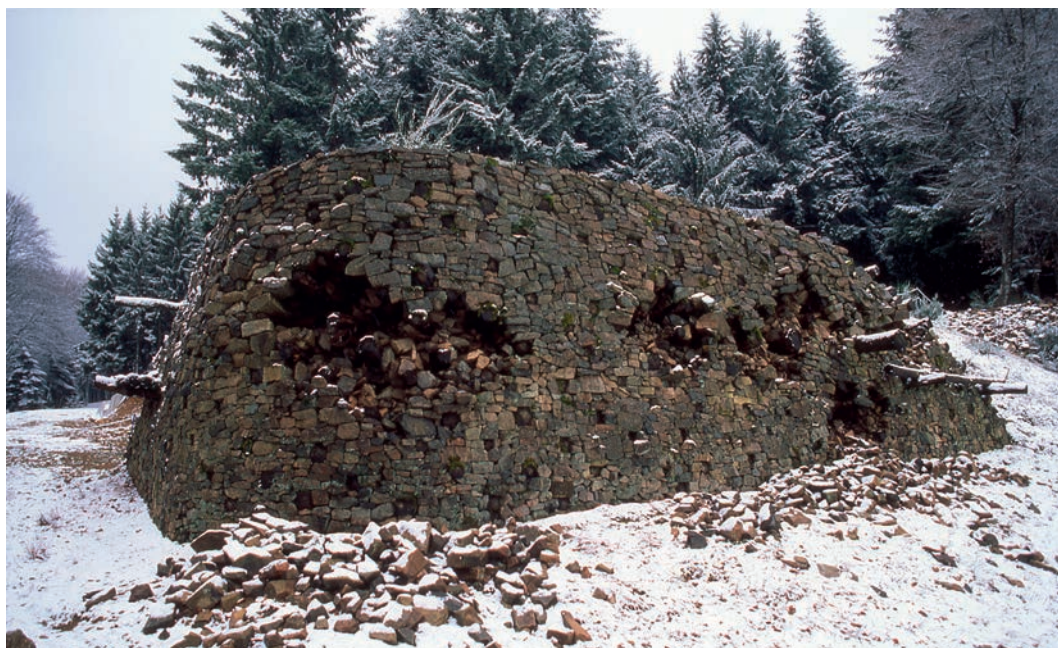
4. Bibracte, Mont-Beuvray. Le suivi des travaux de reconstruction de la Porte du Rebout. Effondrement de la première restitution de la porte (cliché Bibracte/A. Maillier n° 79058)
