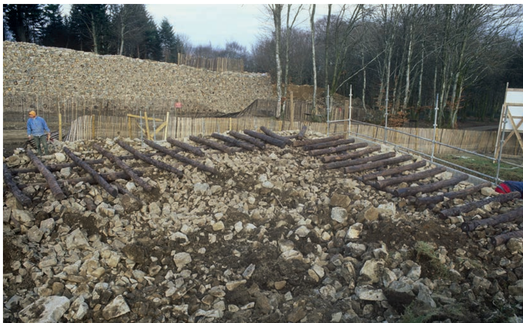
5. Bibacte, Mont-Beuvray. Le suivi des travaux de reconstruction de la Porte du Rebout. Reconstruction du murus gallicus du bastion sud en 2000 (cliché Bibacte/A. Maillier, n° 114579)
