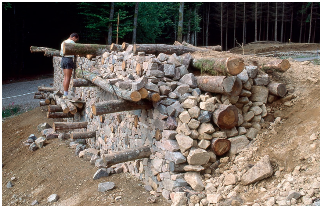
3. Bibracte, Mont-Beuvray. Le suivi des travaux de reconstruction de la Porte du Rebout. Première reconstruction du murus gallicus du bastion nord en 1991 (cliché Bibracte/A. Maillier n° 79047).
