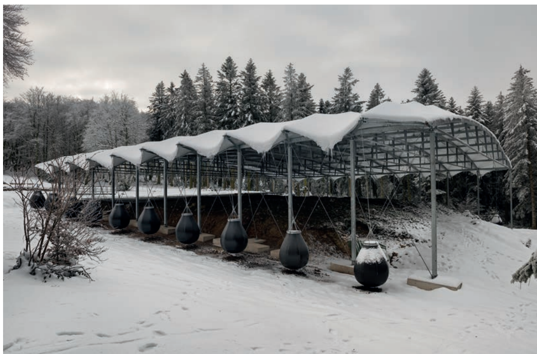
2. Bibracte, Mont Beuvray. La domus PC2. L'abri installé à l'automne 2020 pour protéger la poursuite de la fouille de la domus PC2 vu depuis l'angle nord-ouest vers le sud-est (conception Paul Andreu †, architecte, et agence d'ingénierie T/E/S/S; construction: entreprise SMC2, cliché Bibracte/A. Maillier, n° 127 597).
