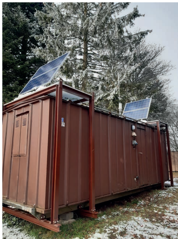
2. Bibracte, Mont Beuvray. Bibracte numérique : projet de développement numérique (2018-2021). Vue des panneaux photovoltaïques fixés sur une cabane métallique de la base vie du chantier école sur la zone PC2. Le routeur, le pare-feu, les convertisseurs et les batteries sont installés dans la cabane (photo Bibracte/J.Langevin).
