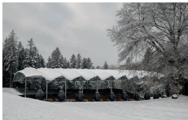
1. Bibracte, Mont-Beuvray. L'abri de 1300 m 2 (36 x 36 m) qui abrite depuis novembre 2020 l'emprise de la domus PC2 (conception : Paul Andreu † , architecte, et agence d'ingénierie T/E/S/S; construction : entreprise SMC2 construction; cliché Bibracte/A. Maillier n° 127592).
