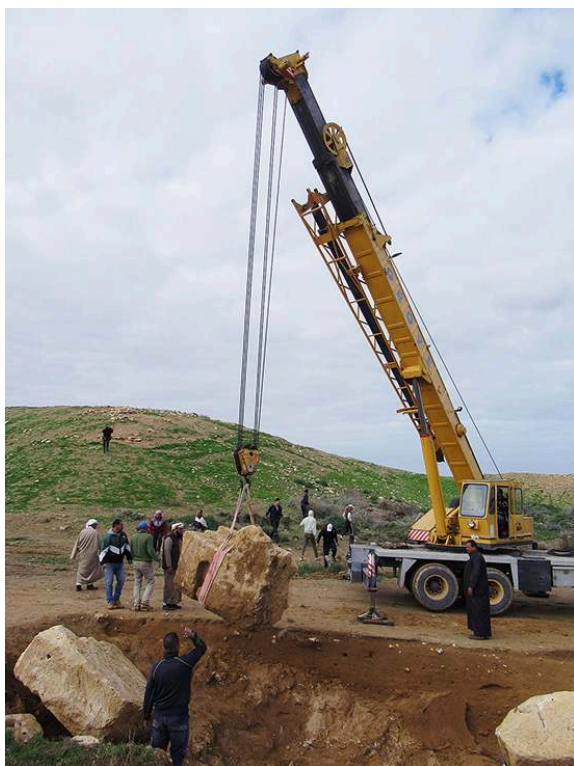
Fig. 5. Kôm Bahig. Levage des gros blocs de calcaire du sondage 20000 le 20 février 2020 (A. Simony).
