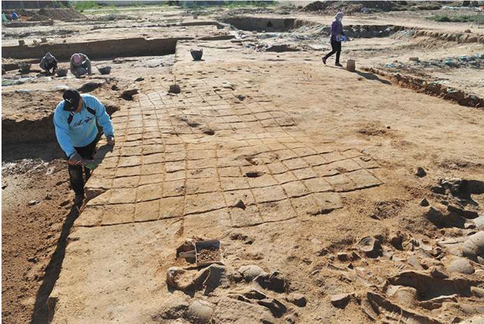
Fig. 33. Akadémia. Secteur 7, sondage 9 vu depuis le nord, troisième sol en briques crues (US 70218) en cours de dégagement, au premier plan rupture dans le sol et US 70242 (V. Pichot).
