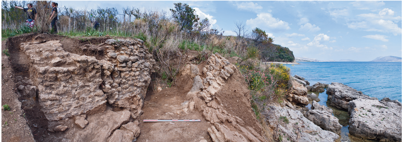
Fig. 5 – Les murs des structures partiellement effondrées sur la terrasse (cliché Ph. Groscaux, AMU, CNRS, CCJ).
