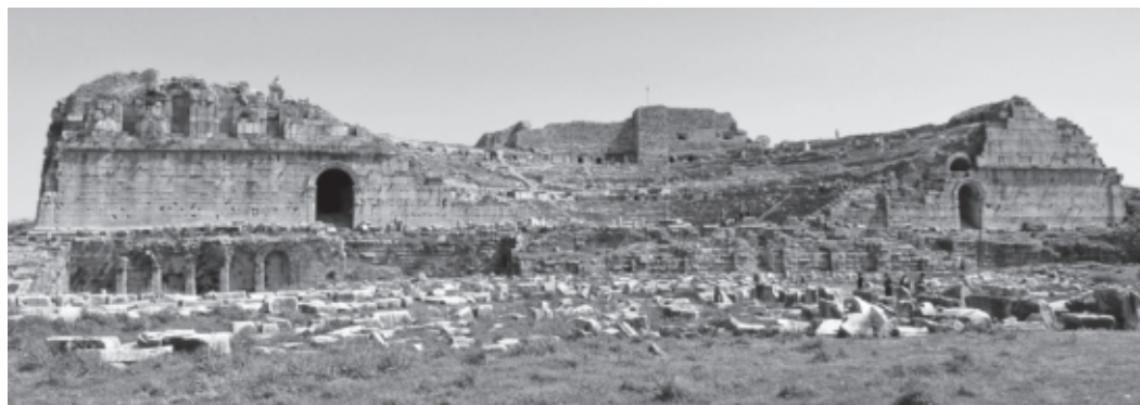
Fig. 2 — Théâtre de Milet. Vue générale depuis l'Ouest (cl. Ph. Niewöhner).
