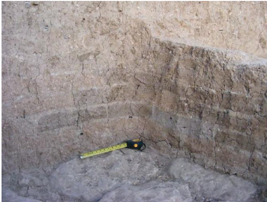
Fig. 66)a : murs 676 et 673 construits avec des briques brunes et grises, séparées par un mortier gris.
