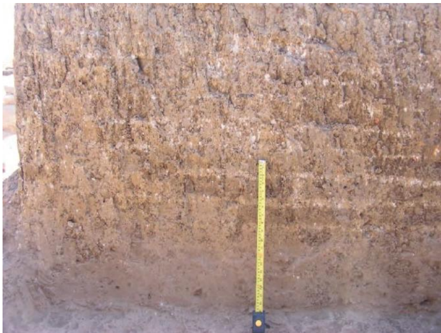
Fig. 66b : mur 813 construit sur sa face ouest avec des briques brunes séparées par un mortier brun-beige riche en craie (Mission archéologique française du Peramagron).
