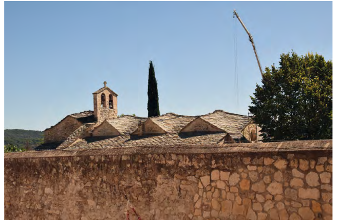
Fig. 21 – SIGONCE, Église Saint-Claude. Couverture de l'église Saint-Claude de Sigonce vue depuis le nord (cliché V. Buccio/SDA-04).
