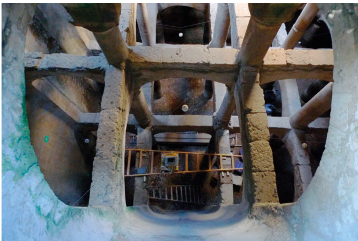
Figure 8 : Vue, depuis l'ouverture zénithale sud durant les opérations d'acquisition tridimensionnelle par lasergrammétrie en 2010, de l'intérieur du réservoir de la citerne avec les trois niveaux de son système de contreventement. Cliché L. Borel, © Archives CEALex
