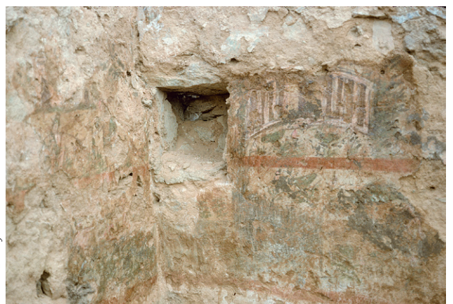
FIG. 16c. Mur est, extrémité gauche.
