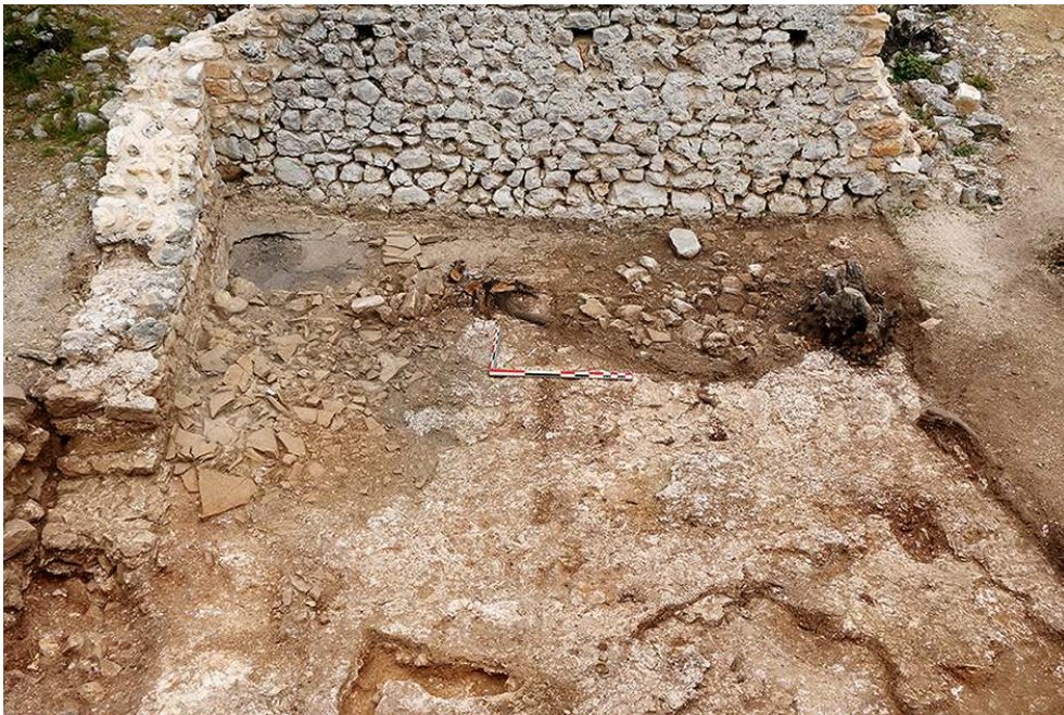
Fig. 5. Niveau de démolition d'une toiture dans l'angle nord-ouest de la nef.
