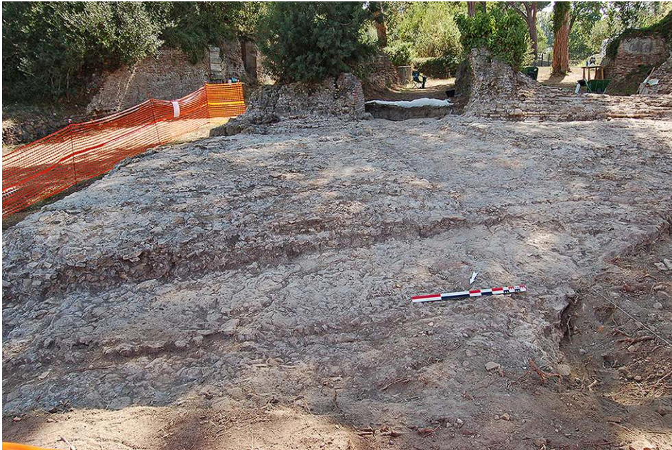
Fig. 2. Vue générale de la structure tardive du môle (USM 22).
