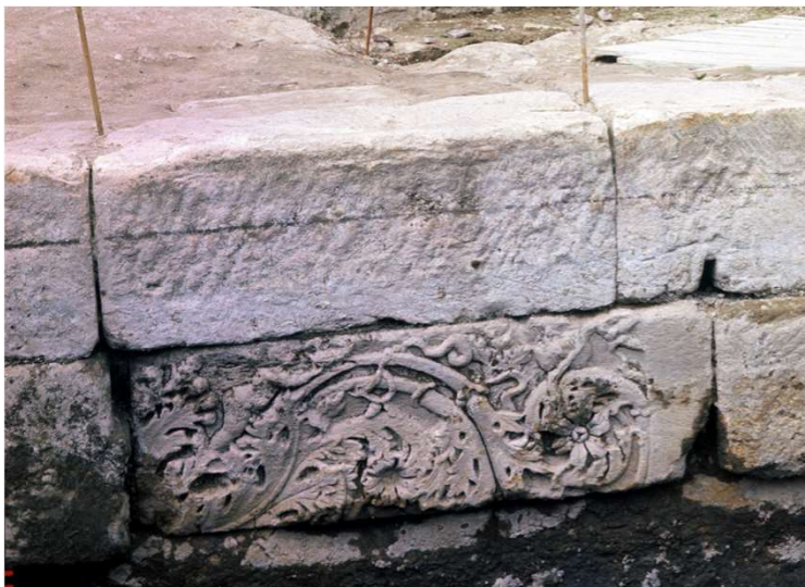
Blocs sculptés réutilisés pour la construction de l'avant-mur © fonds CCJ, photo 1968
