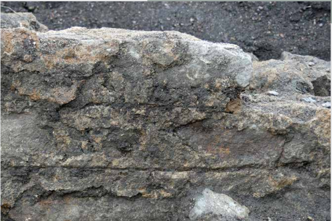
Fig. 3 Parement supérieur de l'enceinte antique côté interne : détail des traces de joints tirés au fer. Cliché Y. Labaune
