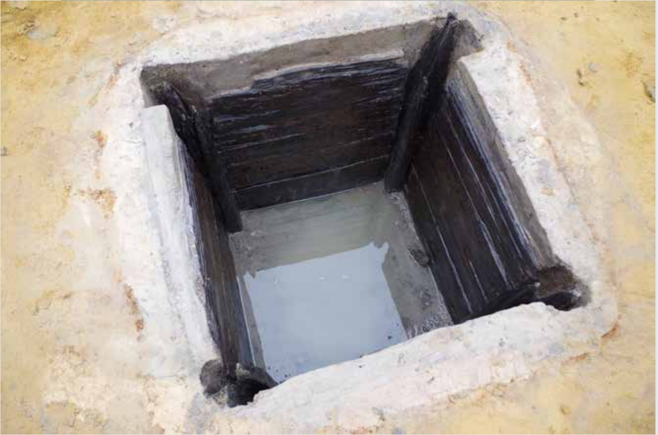
Fig. 5 Cuvelage du puits F10104 (crédit : Archeodunum).
