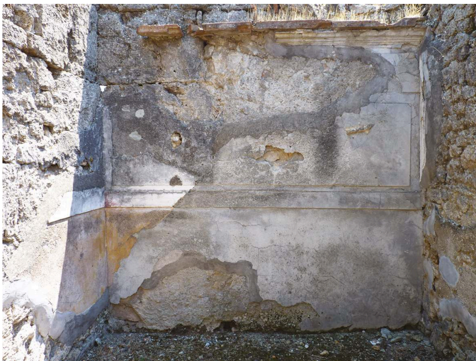
Fig. 8. Décor en I er style de la paroi sud de la pièce (16).
