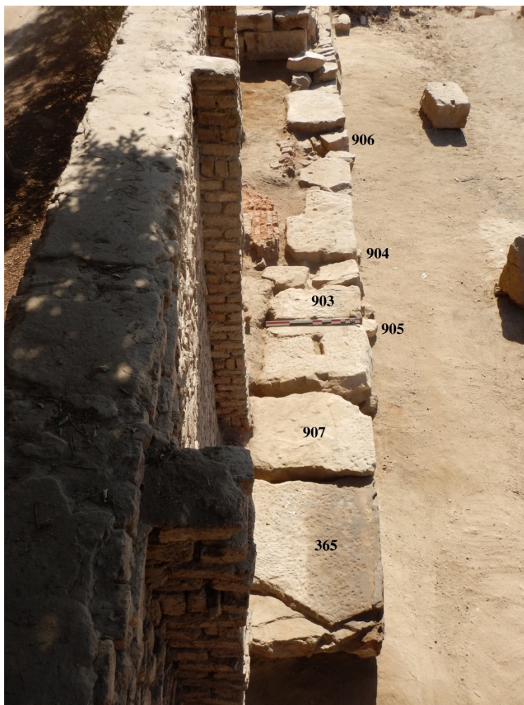
Fig. 5. Portion du mur romano-byzantin en fin d'opération. © CNRS/Chr. Thiers.
