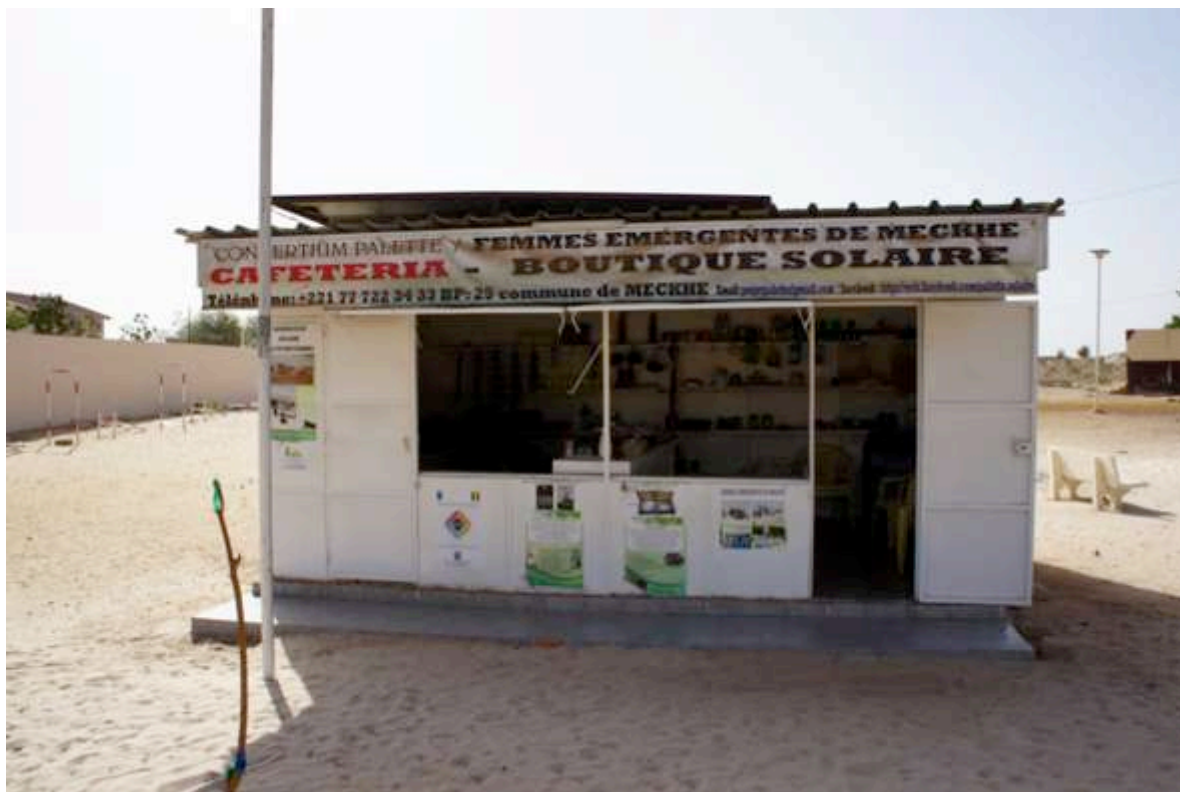
Boutique solaire de Méckhé, avril 2019
