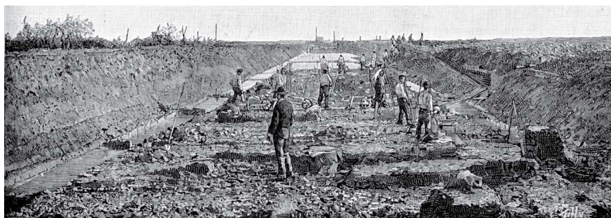
Creusement d'un canal de drainage du marais de Fos en 1890 / Scavo di un canale di drenaggio per le paludi di Fos nel 1890 ( Le magasin pittoresque , vol. 58, 1890, p. 217).
