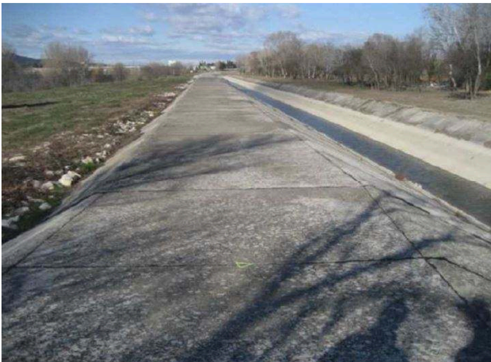
Figure 3 : Le déversoir de Boulbon
