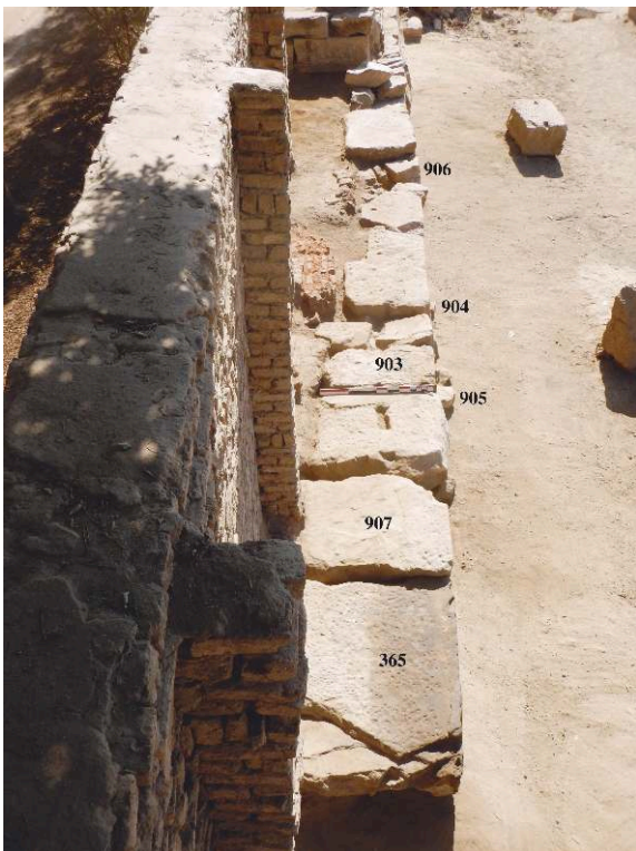
Fig. 5. Vue partielle du mur romano-byzantin (C. Thiers).
