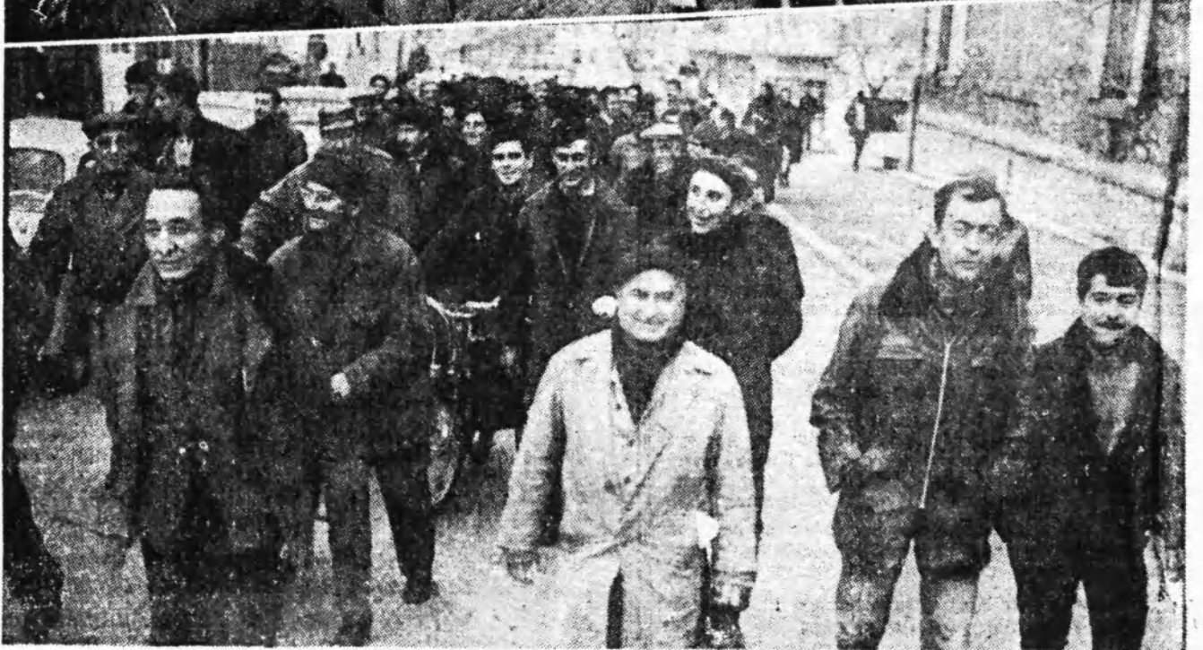
La tribune pendant le compte rendu de Domenech (en haut). Les ouvriers des agglomérés arrivent en cortège devant le chantier principal (cliché du bas).
