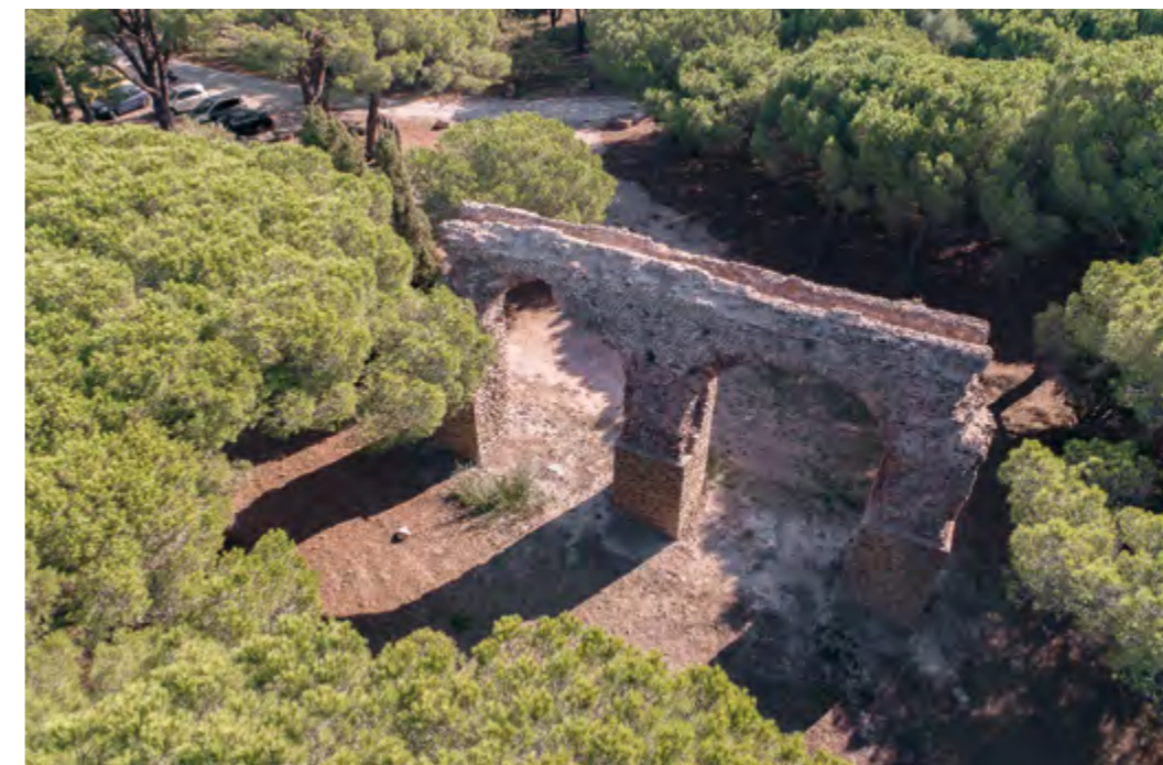
Fig. 163 – FRÉJUS, Aqueduc de Forum Julii, Château Aurélien. Vue aérienne par drone des arches (Ville de Fréjus).
