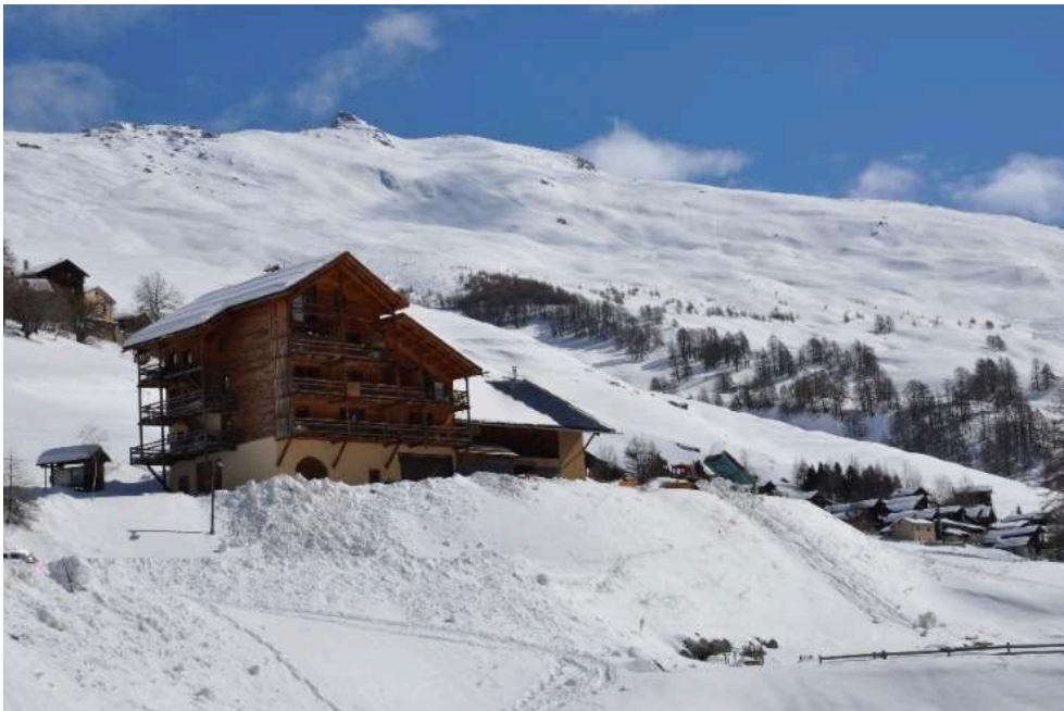
Photo 2 : toiture de la bergerie Saint-Véran
