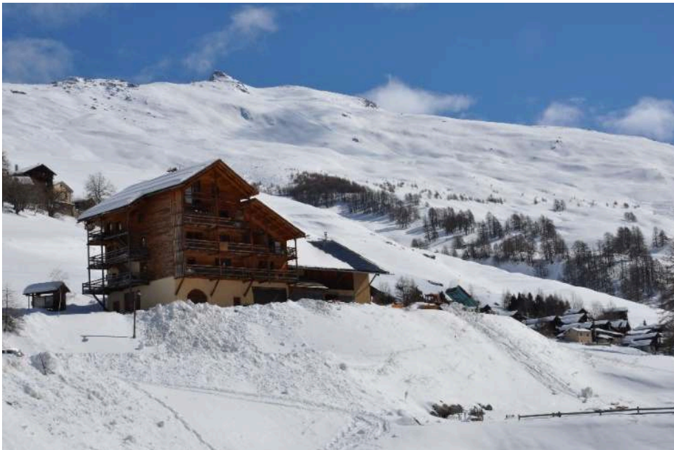
Photo 2 : toiture de la bergerie Saint-Véran
