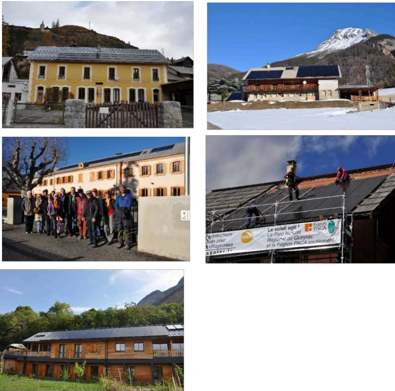
Photos 1 : Exemples de réalisation de toitures par Ener'Guil
