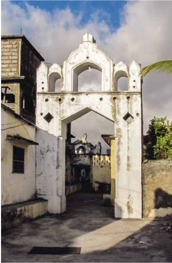
△ Mnara du bangwe (portique de la place) Funi Haziri, à Iconi (côte ouest de Ngazidja).
