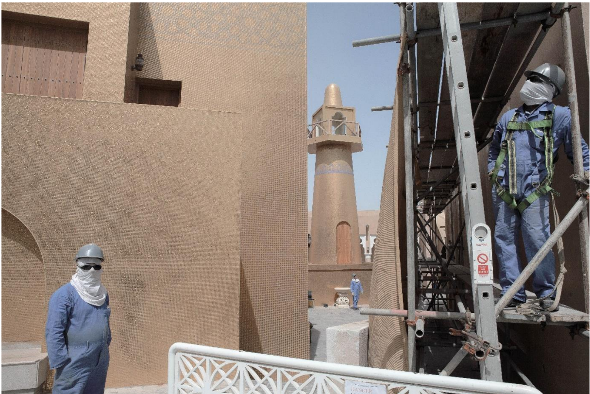
Figure 13 Ouvriers portant un foulard censé limiter les effets de la lumière et de l'air brûlant (32 degrés en ce jour de mars) sur un chantier du "village culturel" Katara, Benchetrit 2011
