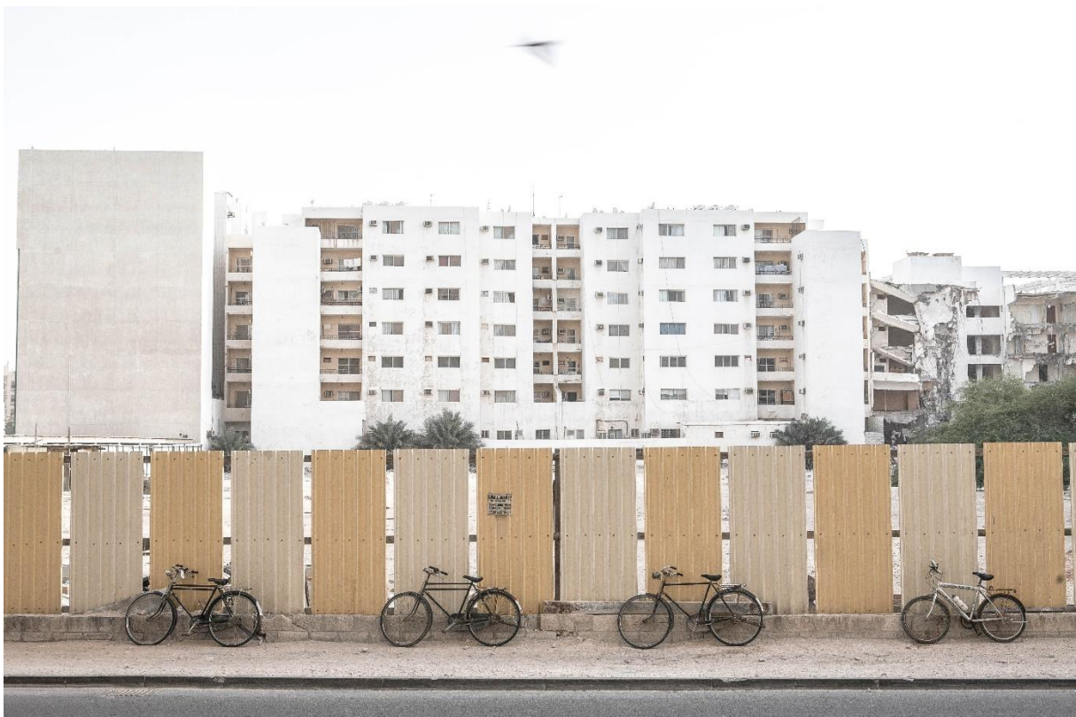
Figure 18 Démolition d'immeubles collectifs en vue de libérer du foncier dans le quartier Al-Sadd ; au premier plan, vélos utilisés par les livreurs, Benchetrit 2011
