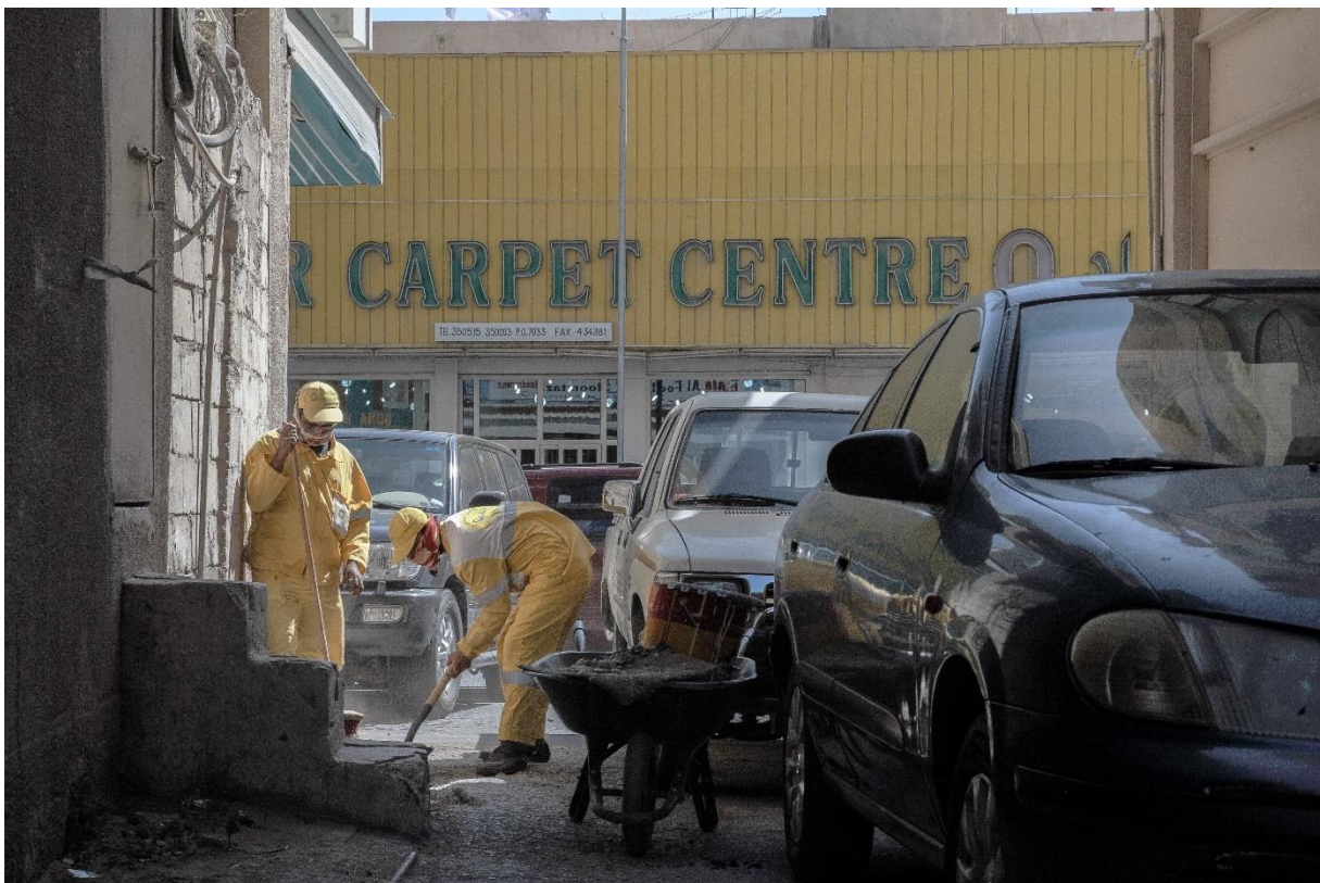
Figure 15 Petit entretien de voirie « à la brouette » dans le centre-ville de Doha, Benchetrit 2011
