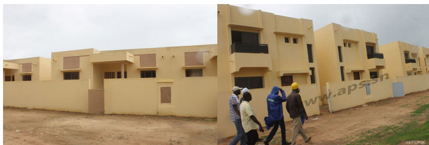
Photo 1 : Construction d'unités d'habitation dans le quartier Kenya
