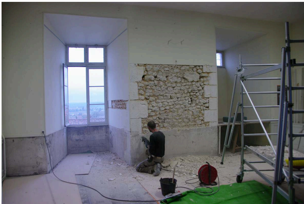
Fig. 6. Barbézieux-Saint-Hilaire (Charente), château, décroûtage des élévations dans le grand logis, dans le cadre d'une opération d'archéologie préventive, fouille Mathias Dupuis, 2011 (cl. M. Dupuis).
