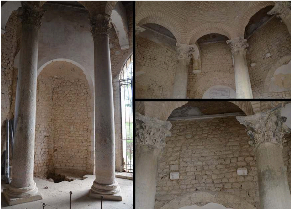
Fig. 7. Riez (Alpes-de-Haute-Provence), baptistère, élévations après décroûtage des enduits des XIX e -XX e siècles, 2014 (cl. M. Dupuis).
