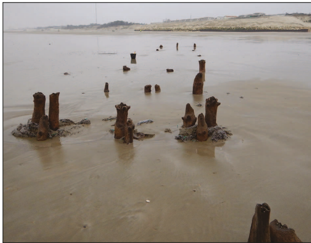
Fig. 17: L'Amélie, bridge/pontoon AML-N-008 (photo F. Verdin). Fig. 17 : L'Amélie, pont/ponton AML-N-008 (photo F. Verdin).
