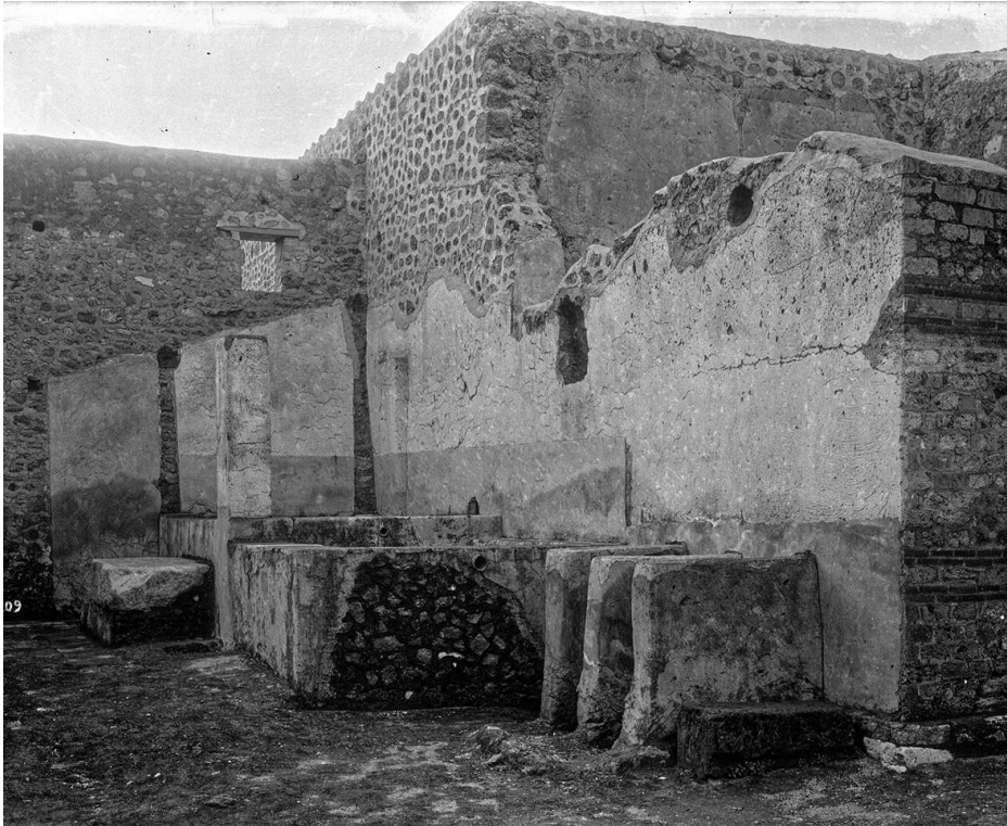
Fig. 31. Pompéi, VI 16, 3-4. L'atelier au moment de son dégagement en 1905.
