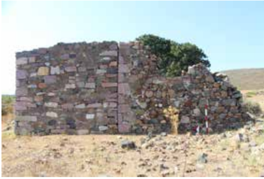
Şekil 6. Çiftliğin güneybatısındaki yapı (ADRA 2021).
