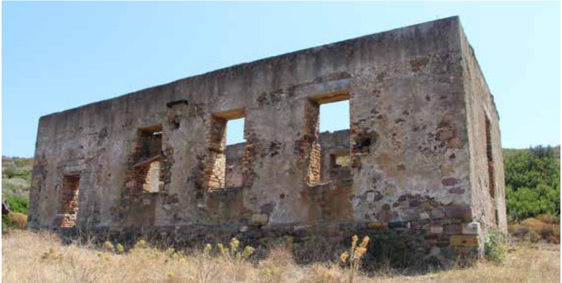
Şekil 15. Maden işletmesinin Büyük Maden Adası kuzeybatı kıyısındaki eski santral binası (ADRA 2016).
