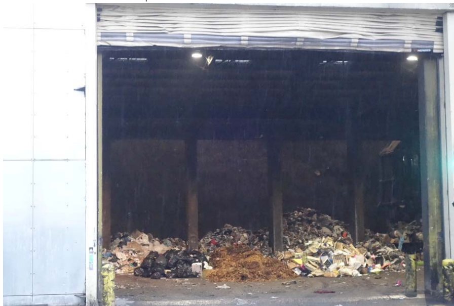
Figure 2 : quai de livraison des déchets devant la fosse d'un de deux fours de l'usine d'incinération.
